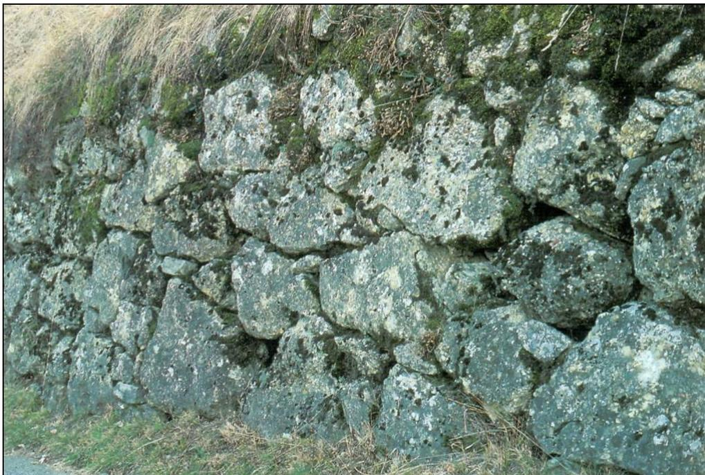
*Muro a secco realizzato con blocchi di pietre appartenenti al Conglomerato di Sirone*
