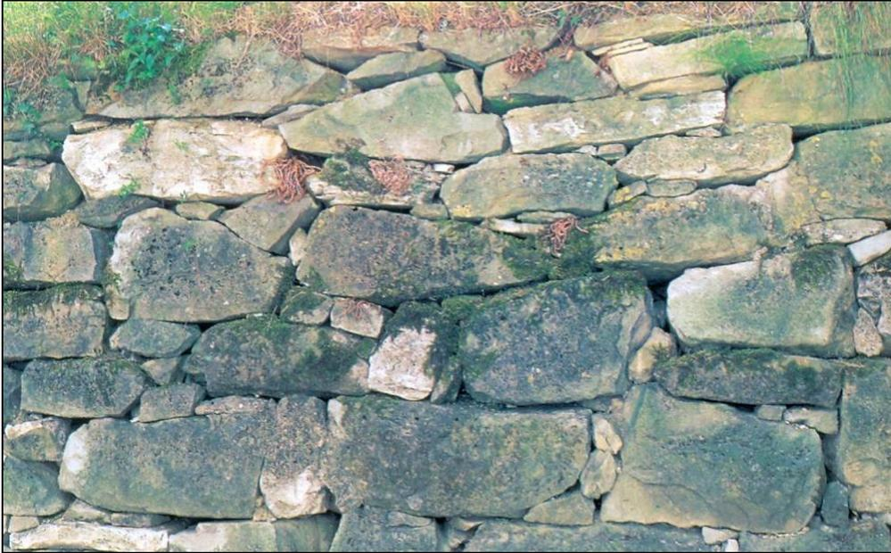
*Muro a secco in arenaria*
